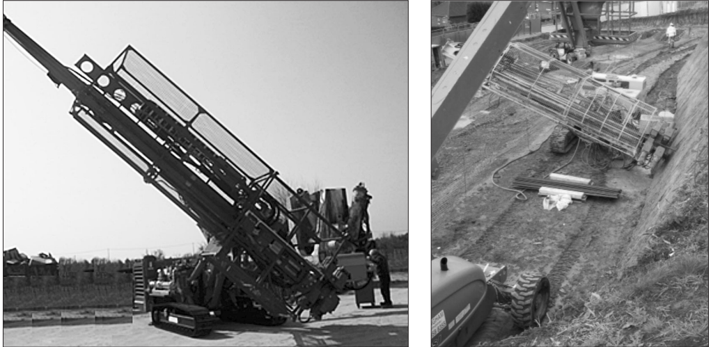
Fig. 6: Perforazioni oblique ed orizzontali
