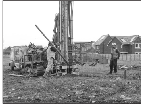
Inserimento e montaggio asta di perforazione
