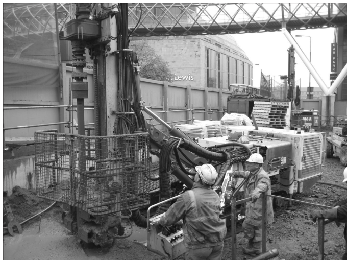
Fig. 5: Perforazioni continue e ravvicinate con mast in verticale
